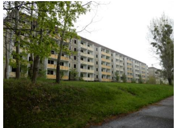
Abbildung 27: Plattenbauten (vermutlich Typ WBS 70
