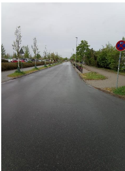
Abbildung 78 Gesamtansicht Demex Allee
