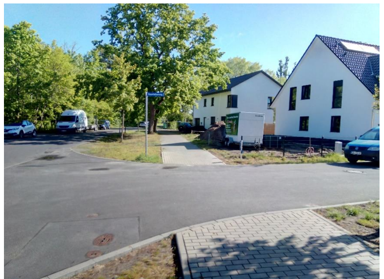
Abbildung 75 Kreuzungsbereich Baumfalkenweg Unter den Kiefern
