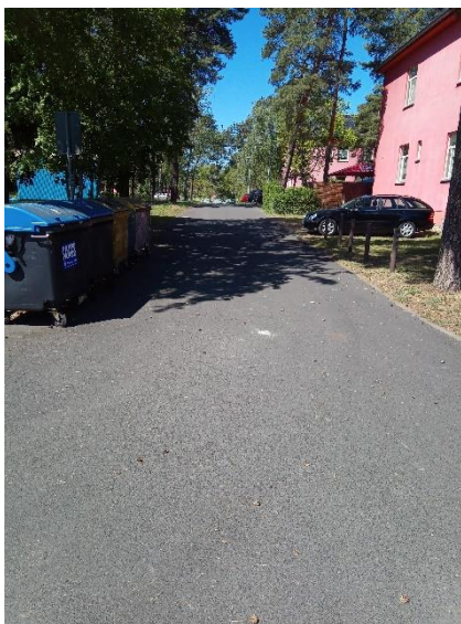
Abbildung 118 Gesamtansicht Stockholmer Straße
