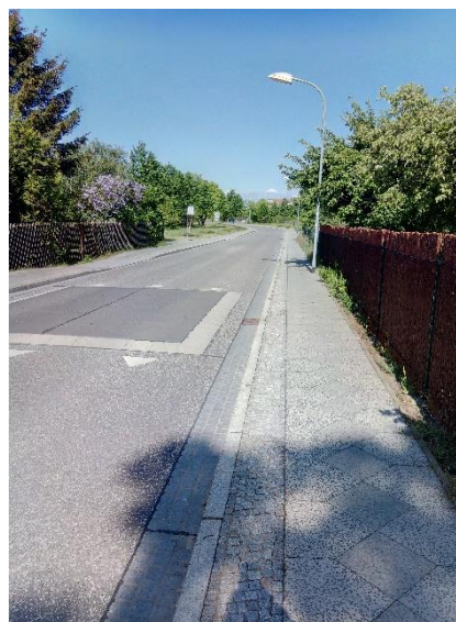
Abbildung 107 Gesamtansicht mit Pflasterkissen
