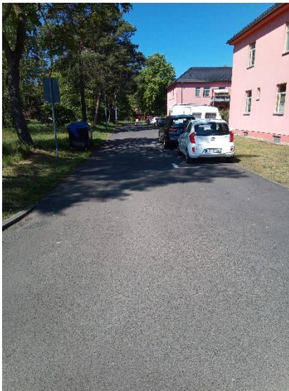
Abbildung 98 Gesamtansicht Londoner Straße
