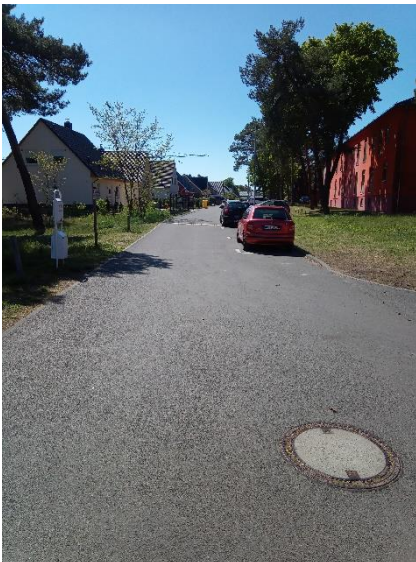
Abbildung 126 Gesamtansicht Zum Wasserwerk
