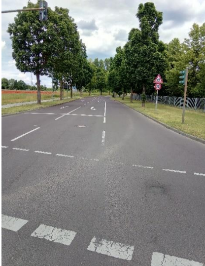
Abbildung 34 Gesamtansicht Neue Bahnhofstraße
