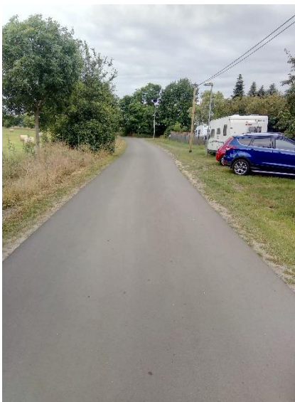
Abbildung 48 Gesamtansicht Rügener Straße
