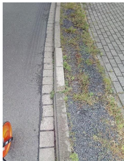
Abbildung 13 beschädigte Borde
