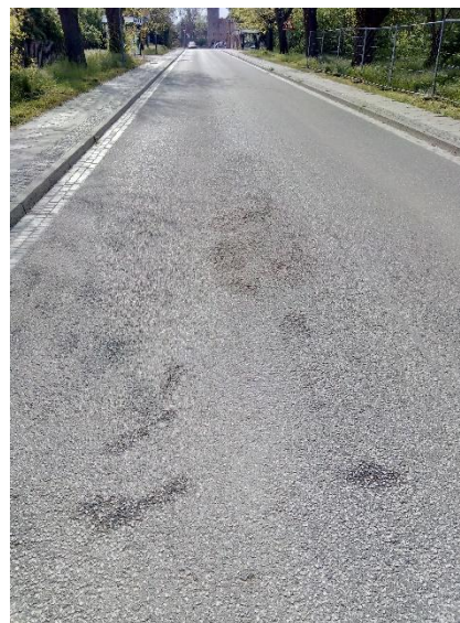
Abbildung 103 entstehende Schlaglöcher
