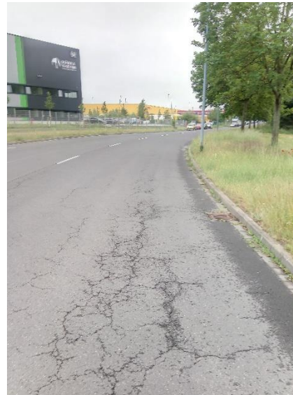
Abbildung 11 Gesamtansicht mit Netzkissen
