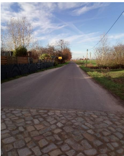
Abbildung 62 Gesamtansicht des Niederhofer Weges
