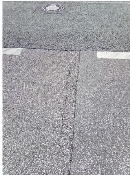
Abbildung 31 Darstellung eines Risses
