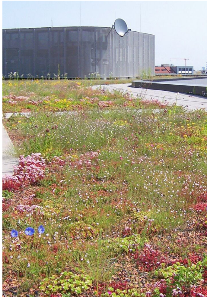
Gründach, extensiv Fahrzeughalle
