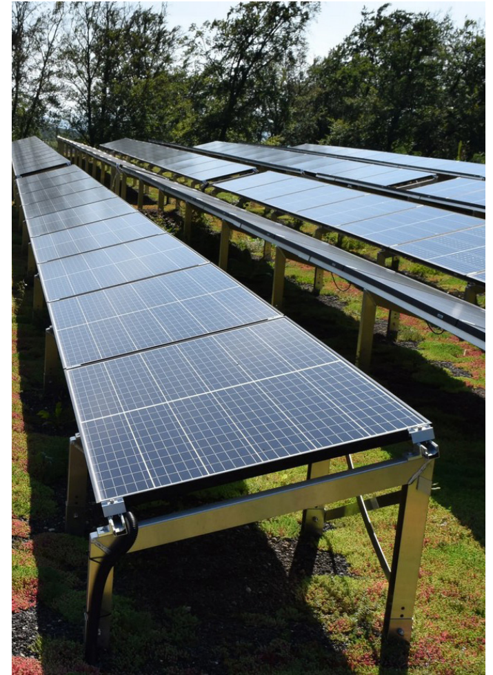
Gründach + PV, extensiv Hauptgebäude
