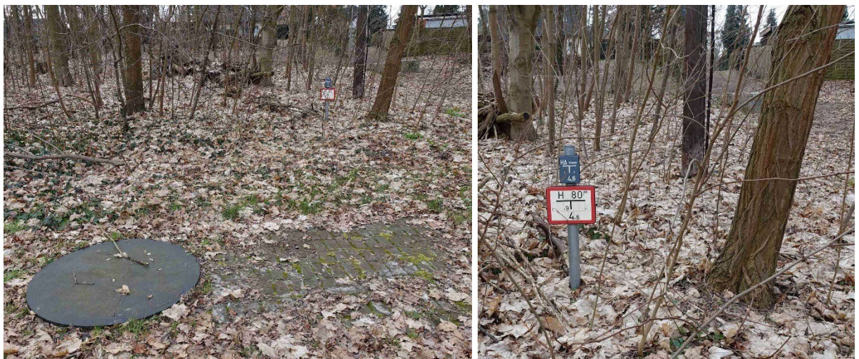
Abb. 24 Hydrant (DN 80) im räumlichen Geltungsbereich an der südlichen Waldkante © Steffen Pfrogner 08.02.2025
